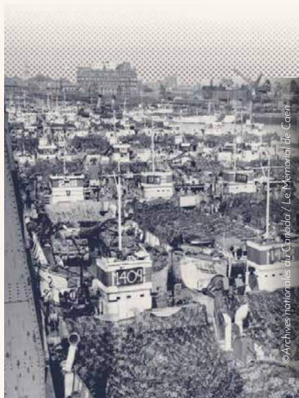
Landing Craft Tank (LCT) camouflés dans le port de Southampton
